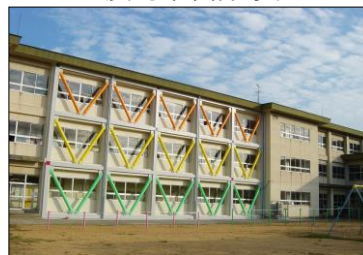
耐震補強工法
