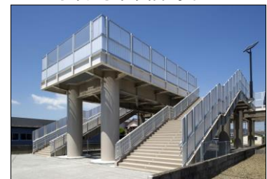
津波避難タワー兼歩道橋
